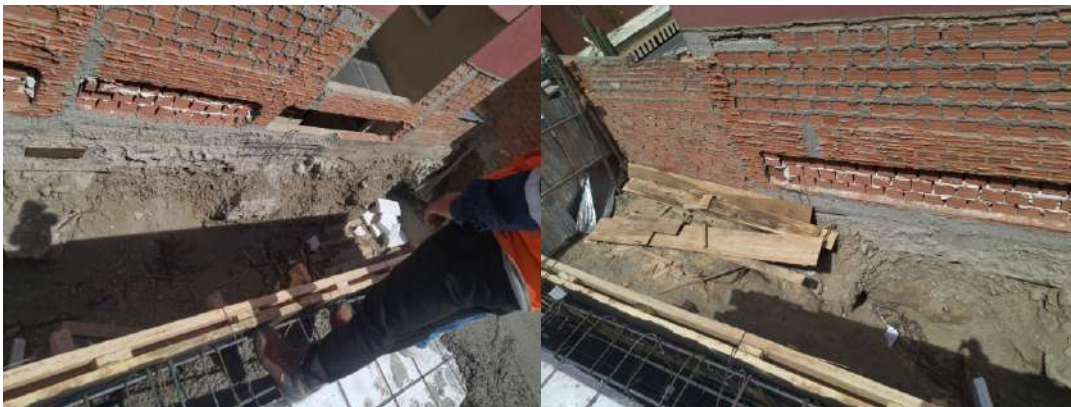
Vista de fase preliminar, actividad de excavación
