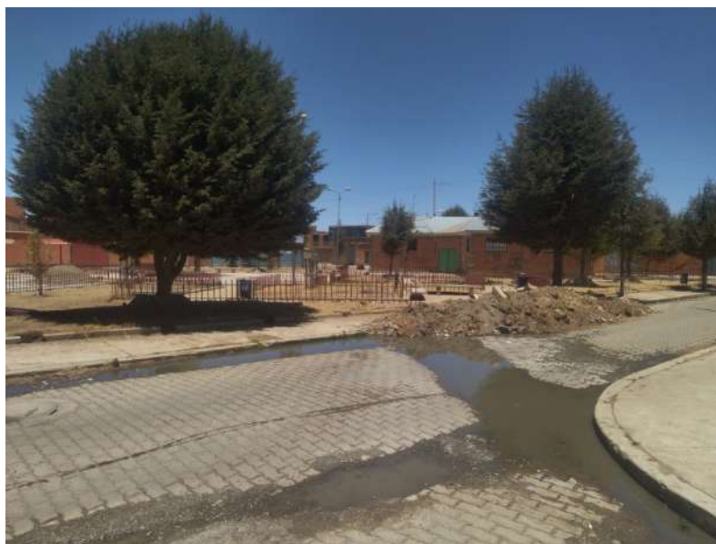
RCD generados por la excavación y limpieza del área de intervención
