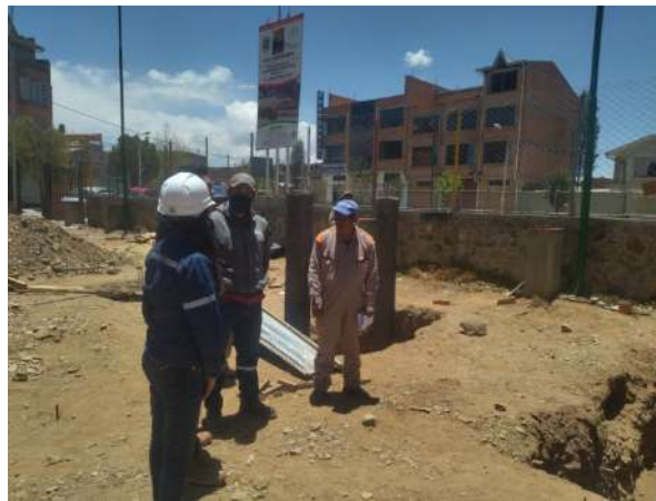
Vista de Excavación de zanjas para el hormigón
