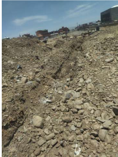
Excavación de zanjas para ducto de drenaje pluvial
