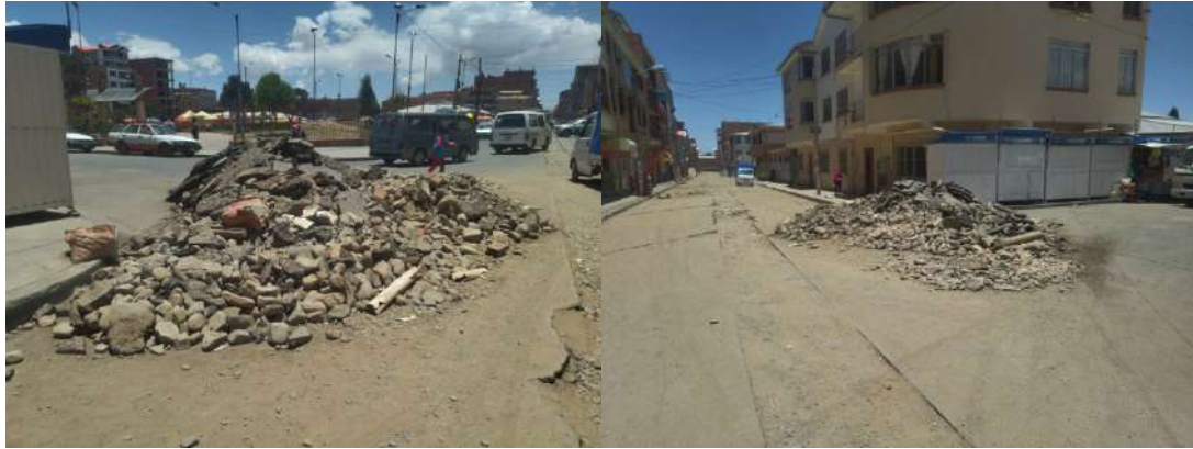
Vista de RCD acumulados, el cual no tiene destino final y temporalmente se encuentra dispuesto en vía pública
