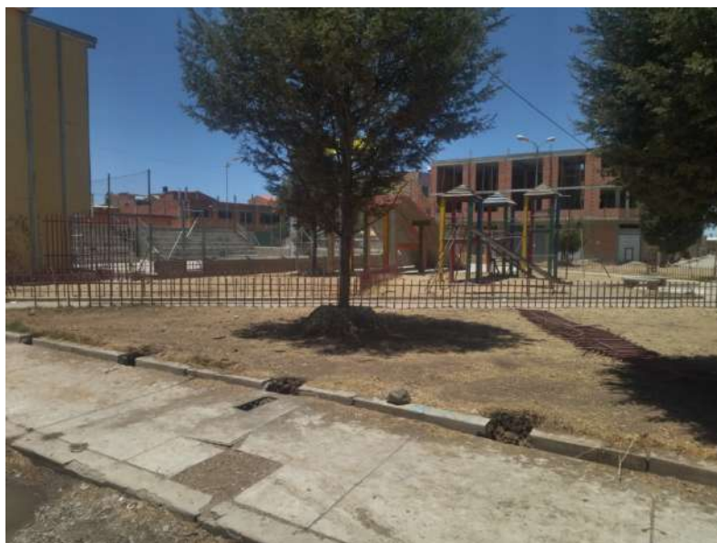
Zanjas para estructura de colocado de hormigón para muro perimetral.
