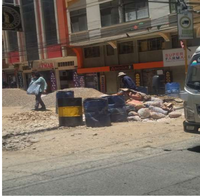
Almacenamiento temporal de material requerido para el pavimentado y acumulación de RCD
