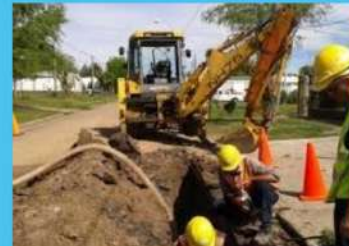
Inspección continua a los trabajos
