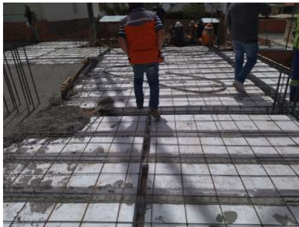
Vista de armado y vaciado de hormigón para la losa
