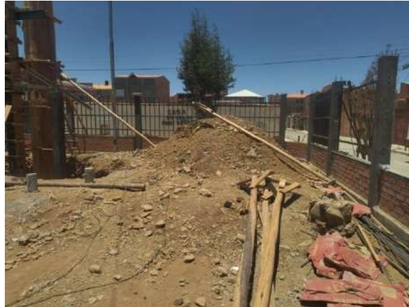
Acumulación de RCD aprovechable, el mismo se generó durante la excavación y ser utilizado como material de relleno en la obra
