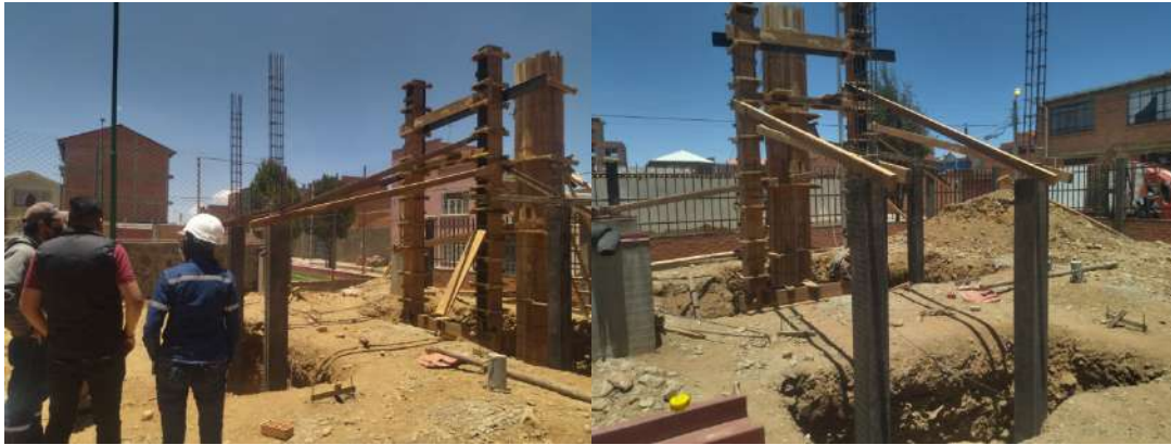
Vista de levantamiento de zapatas y columnas, excavación para colocado de hormigón
