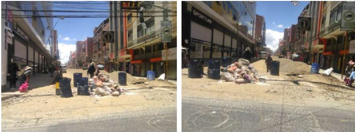
Vista Panorámica del trabajo de asfaltado de avenida
