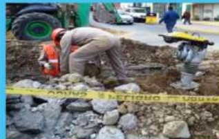
Retiro de rocas de los trabajos de excavación
