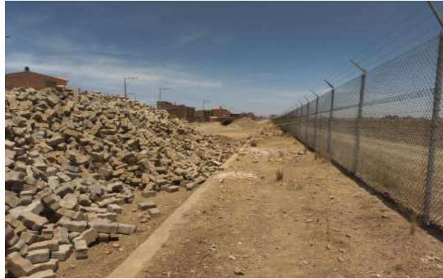
Almacenamiento temporal de material de relleno para la vía
