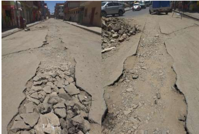
Vista del trabajo terminado de cambio de embovedado.
