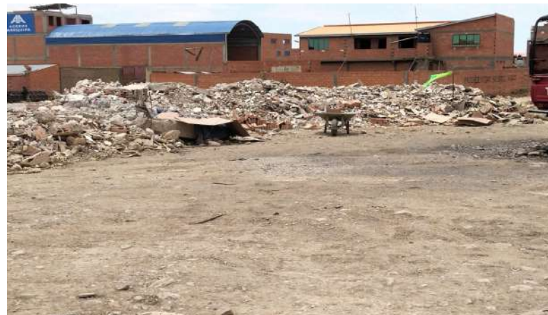
Fotografía 2. Recuperación de ladrillo en Rio Negro
