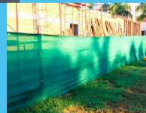
Instalación de semisombra
