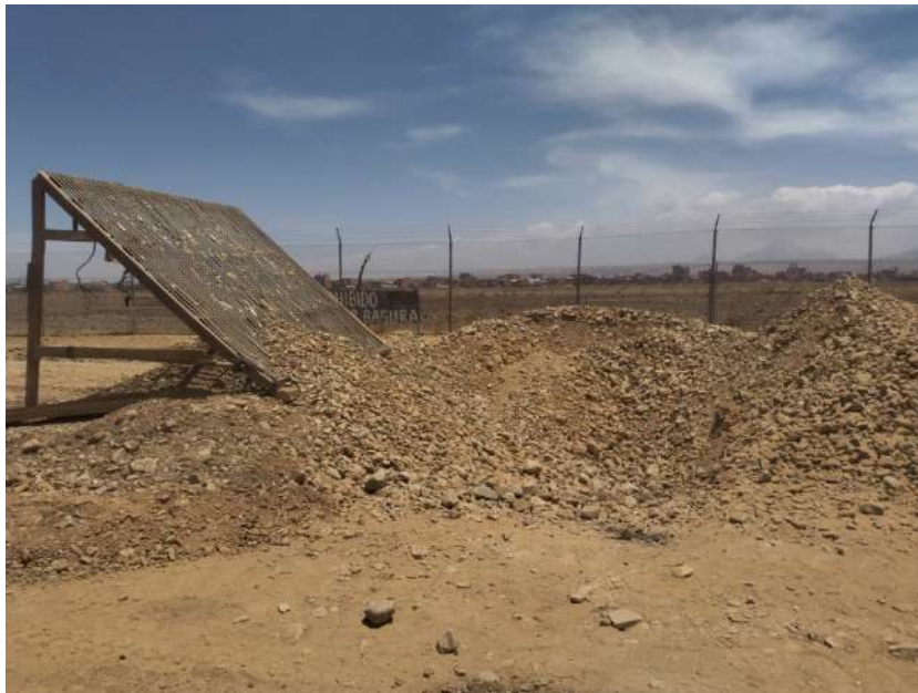
Separación de material de relleno de acuerdo a la granulometría.
